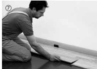
Оставшаяся часть первого ряда служит началом следующего ряда (смещение с торцовой стороны не менее 50 см). Благодаря этому существенно уменьшается количество отходов. Далее выполняется укладка отдельных элементов. Для этого элементы сначала вставляются продольной стороной с помощью легкого нажатия с поворотом в смежную доску.
