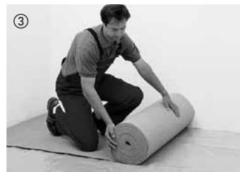
Для изоляции ударного шума и для сглаживания небольших неровностей укладывается заподлицо пробковая изоляционная подкладка толщиной 2 мм. Альтернативные изоляционные подкладки представлены в нашем ассортименте вспомогательных материалов. Битумный картон непригоден для изоляции ударного шума. Для ламинированных покрытий HARO с Silent Pro® не разрешается применять дополнительную изоляционную подкладку.
