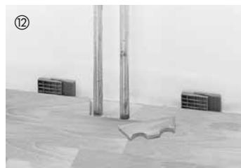
Для труб отопления, выходящих из пола, в элементах вы сверливаются или выпиливаются отверстия (размер отверстий зависит от диаметра трубы отопления с учетом необходимого зазора для температурного расширения).
