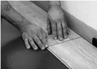
Следующие элементы первого ряда защелкиваются сверху на торцах в предыдущую доску. После быстрого нажатия на поперечный стык элемент входит в зацепление со смежным элементом. При этом необходимо обращать внимание на точную соосность элементов. Последний элемент первого ряда должен быть отрезан так, чтобы между ним и стеной оставался расширительный зазор 10-15 мм, и вставлен в смежный элемент.
