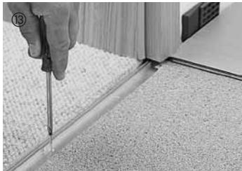
Для обеспечения компенсационного зазора в дверных проходах необходимо всегда применять соответствующую систему профилей. Это следует делать также и тогда, когда в прилегающем помещении укладывается такой же пол. В этом случае для соблюдения компенсационного шва необходимо применять переходной профиль.
