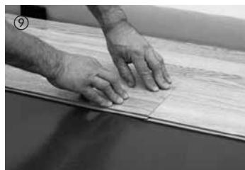
Затем элемент опускается с торцовой стороны. При этом следите за тем, чтобы элемент с торцовой стороны соединился встык с предварительно уложенным элементом и находился на одном уровне с ним. После быстрого нажатия на поперечный стык элемент фиксируется.
