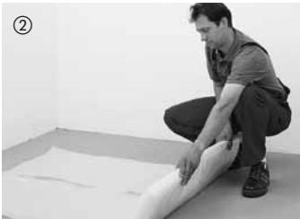
Для всех видов бесшовных стяжек и при укладке на обогреваемый пол следует всегда подкладывать полизиленовую пленку толщиной 0,2 мм. В зоне стыков внахлест пленки должен составлять 30 см. Уложенную пленку следует подтянуть вверх возле стены и после монтажа плинтуса отрезать выступающий край.
