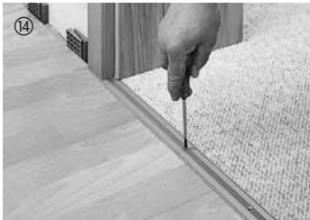
В шине необходимо соблюдать компенсационный зазор 5 мм. Деревянные дверные рамы должны всегда обрезаться на толщину паркетного элемента пилой для чистовой распиловки, чтобы ламинатный пол имел возможность расширения. После укладки необходимо в обязательном порядке удалить распорные клинья. Прикрепите плинтусы к стене (с зажимами или без них) – и все готово.
